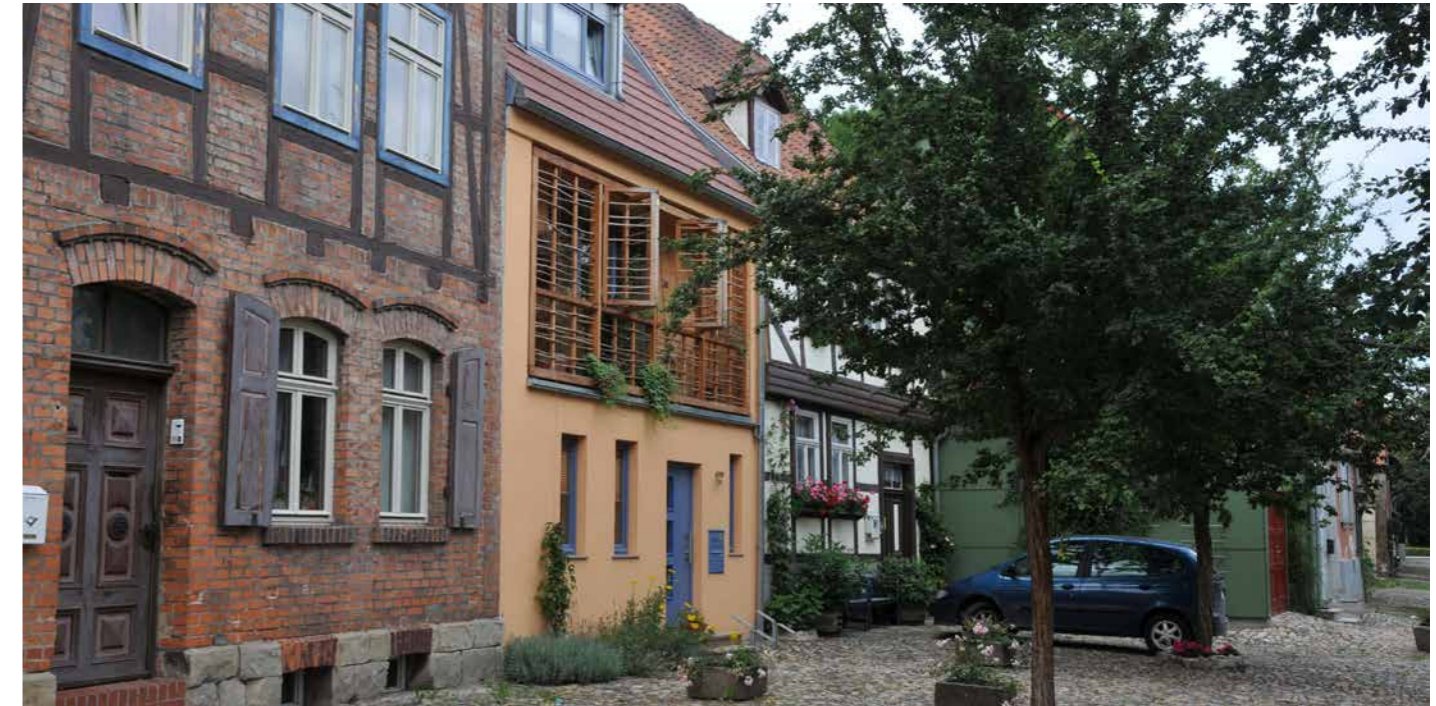
Baulückenschließung in historischer Umgebung – Reichenstraße in der Altstadt von Quedlinburg
