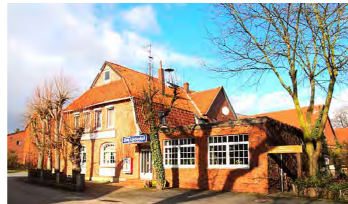
Die künftige Heimstatt des Dorfladens und Dorfgemeinschaftshauses Linsburg. Ausgangssituation vor dem Um- und Ausbau – Februar 2016
