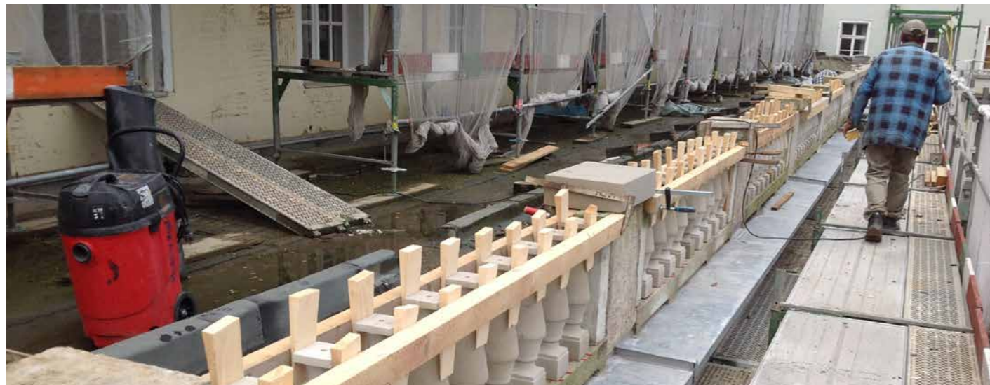
Umbau und Sanierung des „Palais im Park“ in Bad Eilsen: nachempfundene, neu eingesetzte Baluster aus Obernkirchener Sandstein
