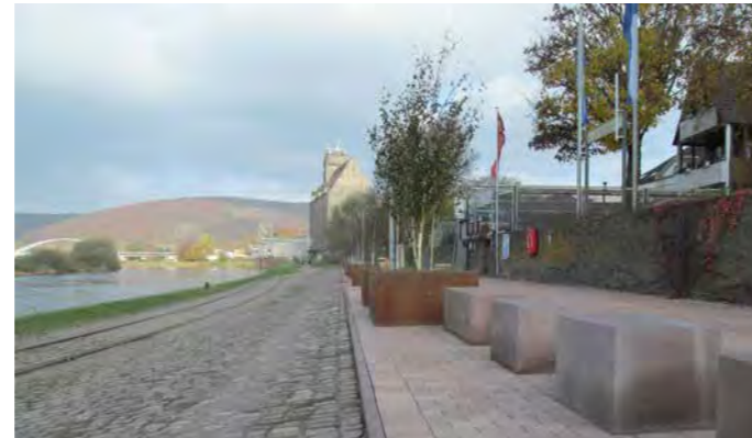
Sitzstufen und Pflanzkübel auf dem Weserkai als trennendes Element zwischen Umschlaghafen und Aufenthaltsbereich
