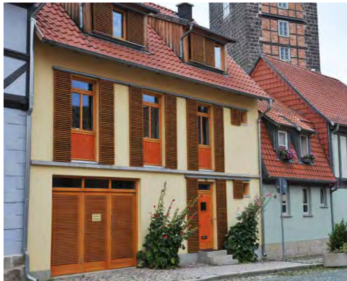
In der Altstadt von Quedlinburg – die stehenden, mit Läden schließbaren Fenster greifen die Kleinteiligkeit der Umgebung auf, im Erdgeschoss wurde eine Garage untergebracht
