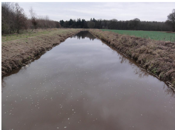
Abb. 3-1: Planbereich im Dezember 2013 (Blick von „Engländerbrücke“ Richtung Süden) (Foto: GEUM.TEC)
