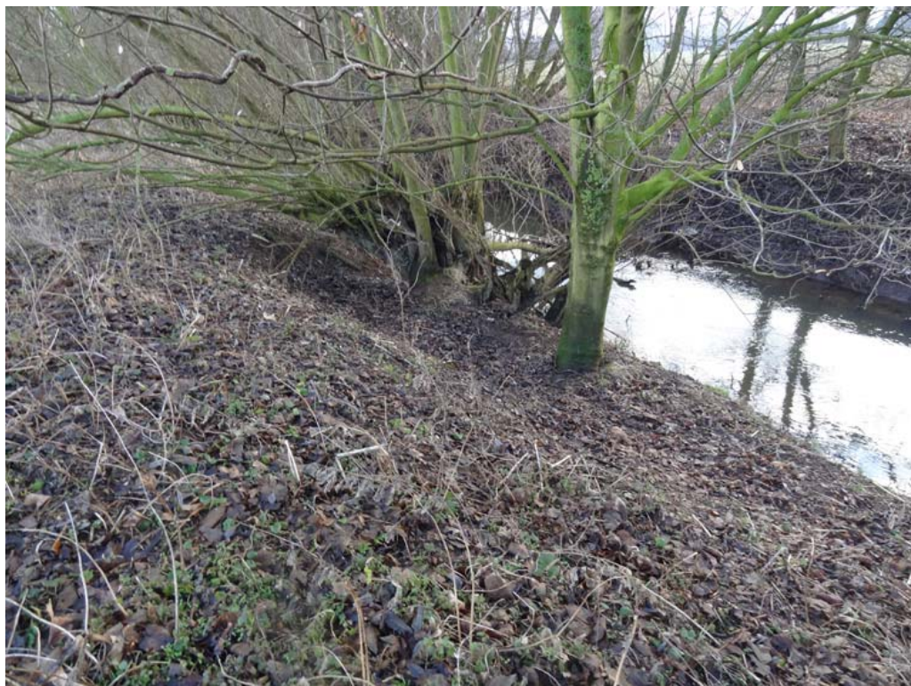
Abb. 6: Bei der Anlage der Hochwasserberme kann der Ufergehölzsaum erhalten werden. Die Fußpunkte der Bäume liegen dafür tief genug.
