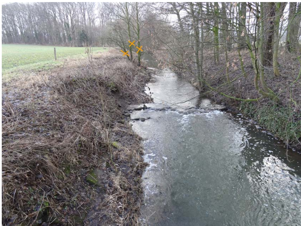
Abb. 4: Blick von der alten Südaue-Brücke stromaufwärts. Für die hydraulisch notwendige Hochwasserberme müssen zwei Ahorne und ein Holunder entfernt werden.
