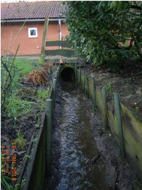
Abb. 3 Stark eingeschränktes Gewässerprofil mit Verlauf unterhalb von Gebäuden
