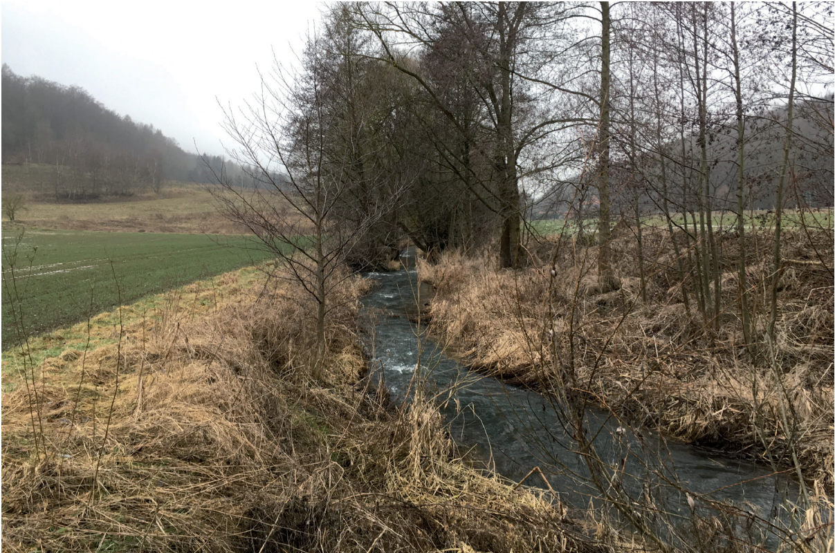
Abb. 2.0: (BÜRO FÜR FREIRAUMPLANUNG, 2017): Gleich hinter der Brücke der Ortschaft Linnenplan verläuft die Lenne geradlinig mit geringer Breitenvarianz und wenig hydromorphologischen Elementen, rechts abgeschnitten von der Aue.
