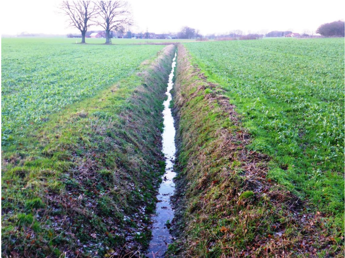
Abbildung 3: Retzer Bach am Beginn der Maßnahmenstrecke im Winteraspekt (14.01.2019).
