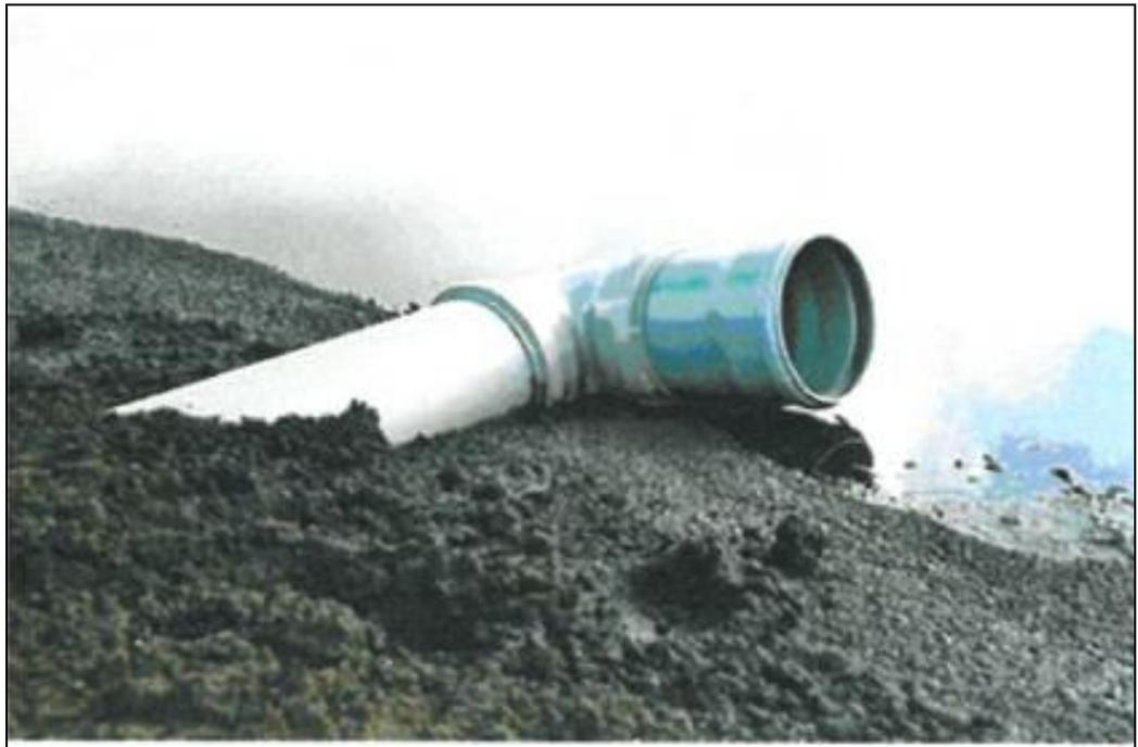
Abb. 4.2: KG-Rohr mit Bogenstück zur Steuerung der Wasserstände auf den Rückhalteflächen (NLFB, 2004)
