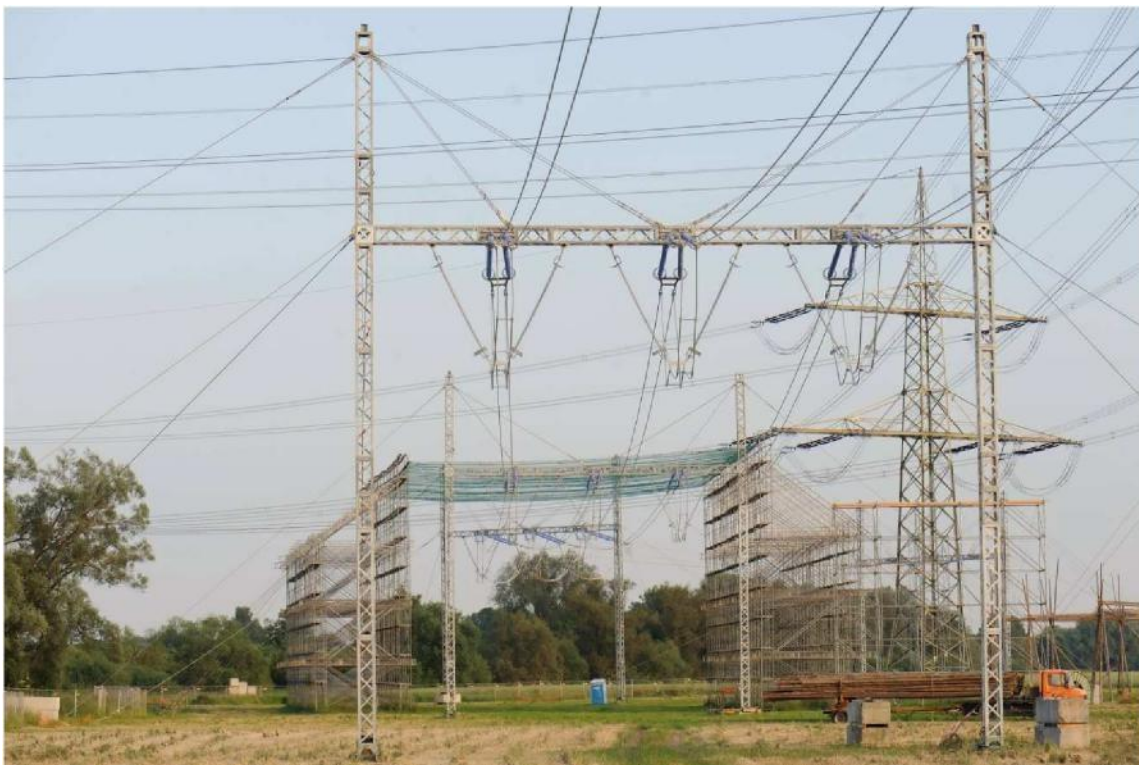
Abbildung 5: Einsatz von Provisorien (380-kV-Freileitungsprovisorium für ein System, mit errichtetem Schutzgerüst im Hintergrund) (Quelle: TenneT TSO)
