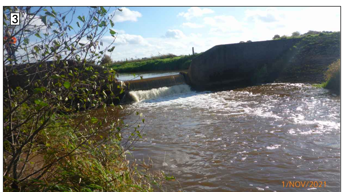
Schwelle Wehr 4 Klärwerk Barver
