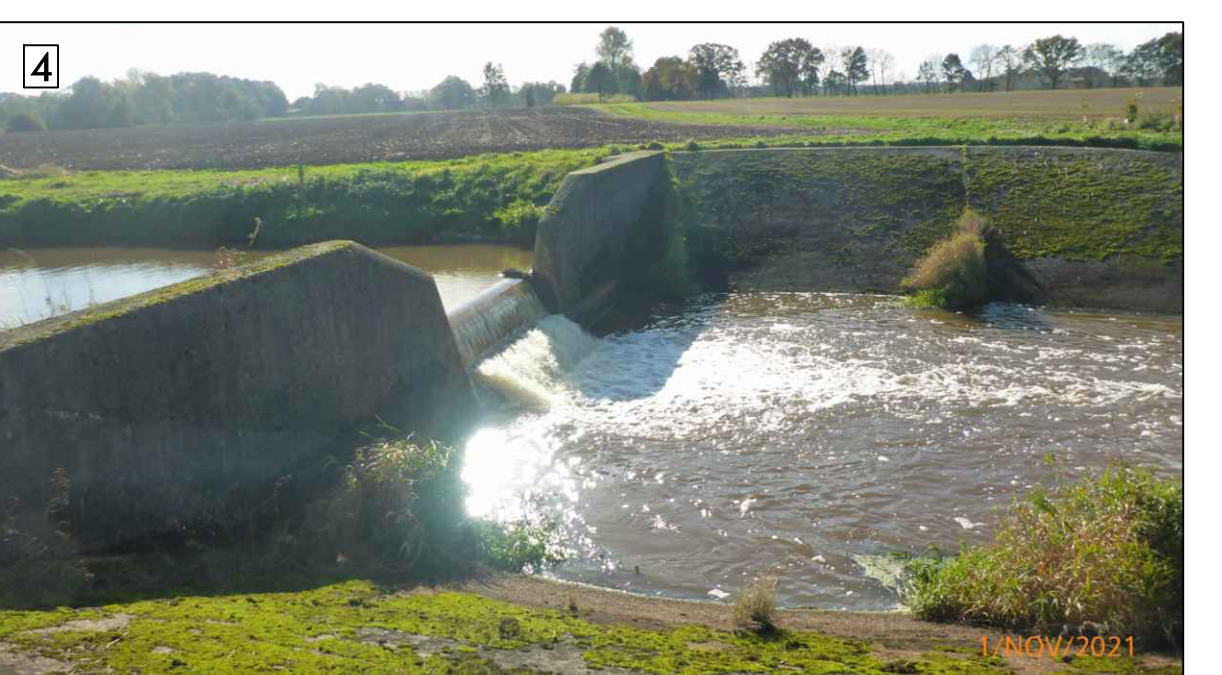
Schwelle Wehr 4 Klärwerk Barver
