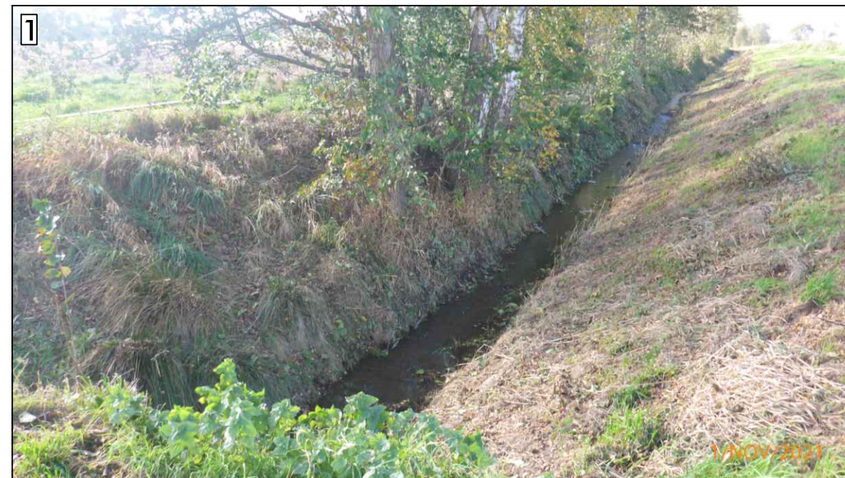
Blickrichtung Dickeler Kanal entgegen Fließrichtung
