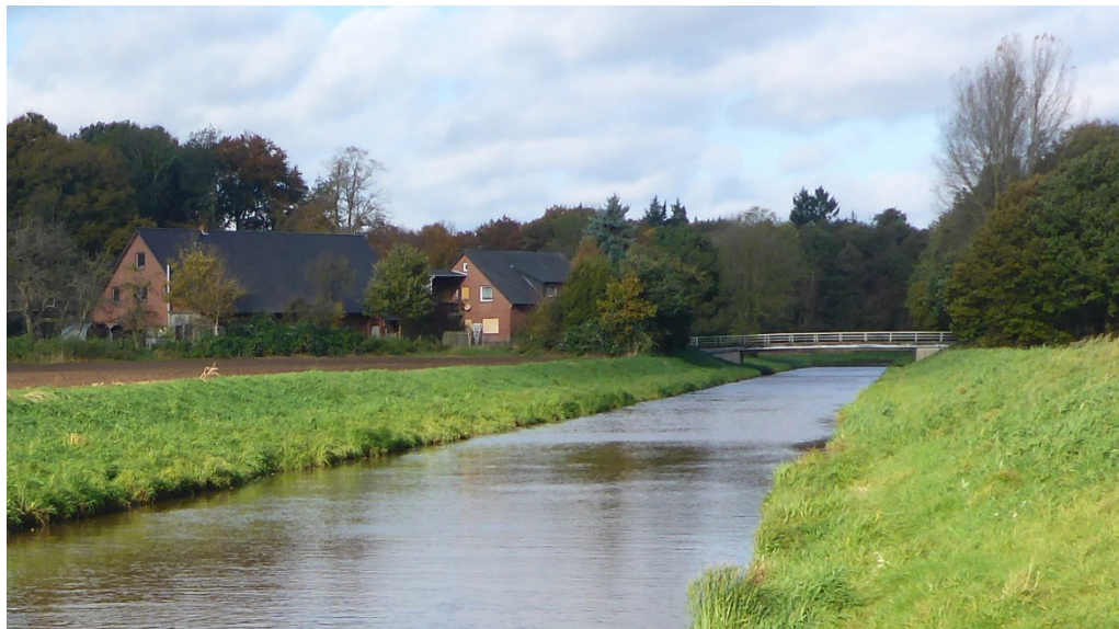
Abbildung 3: Brücke Helmsmühle (Blickrichtung in Fließrichtung)
