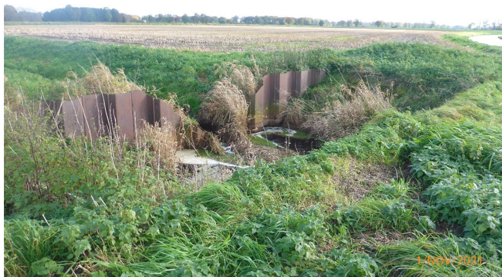
Abbildung 8: Sohlabsturz Freistätter Moorkanal inkl. Rechteckdurchlass (Überfahrt Vordergrund)
