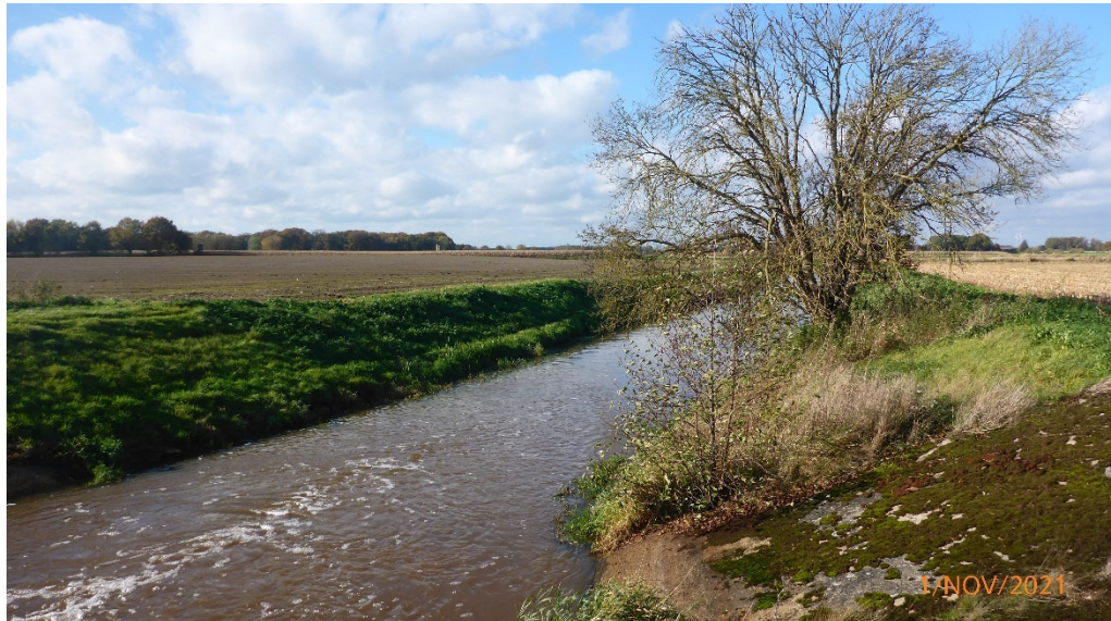
Abbildung 24: Gehölz an Wehr 4 - Klärwerk Barver [Blickrichtung in Fließrichtung]
