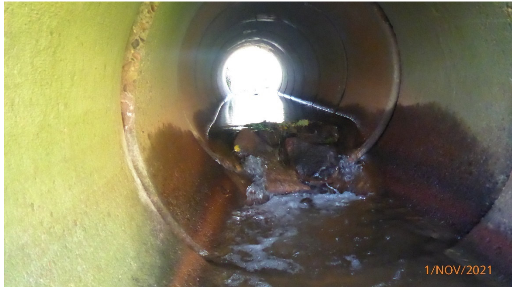
Abbildung 7: Sohlabsturz im Durchlass des Dickeler Kanals
