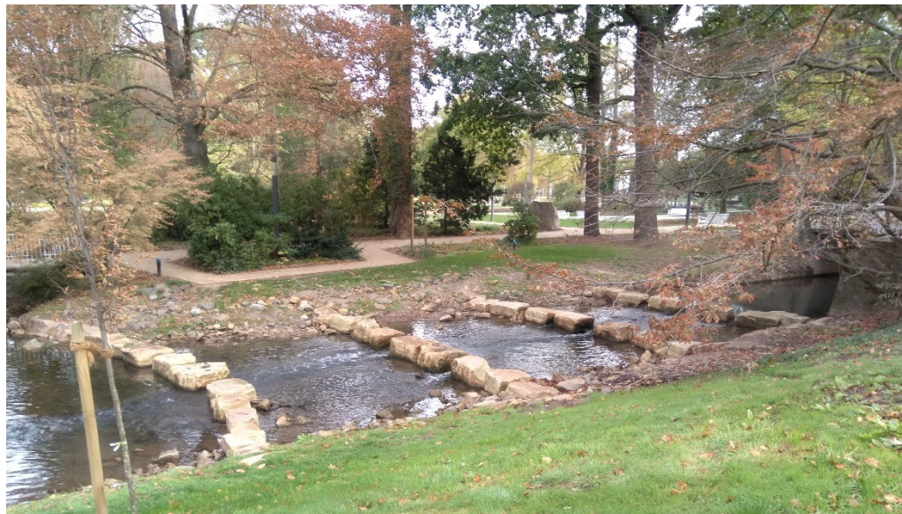
Abbildung 28: Beispiel Raugerinne in Beckenbauweise an der Salze in Bad Salzuflen
