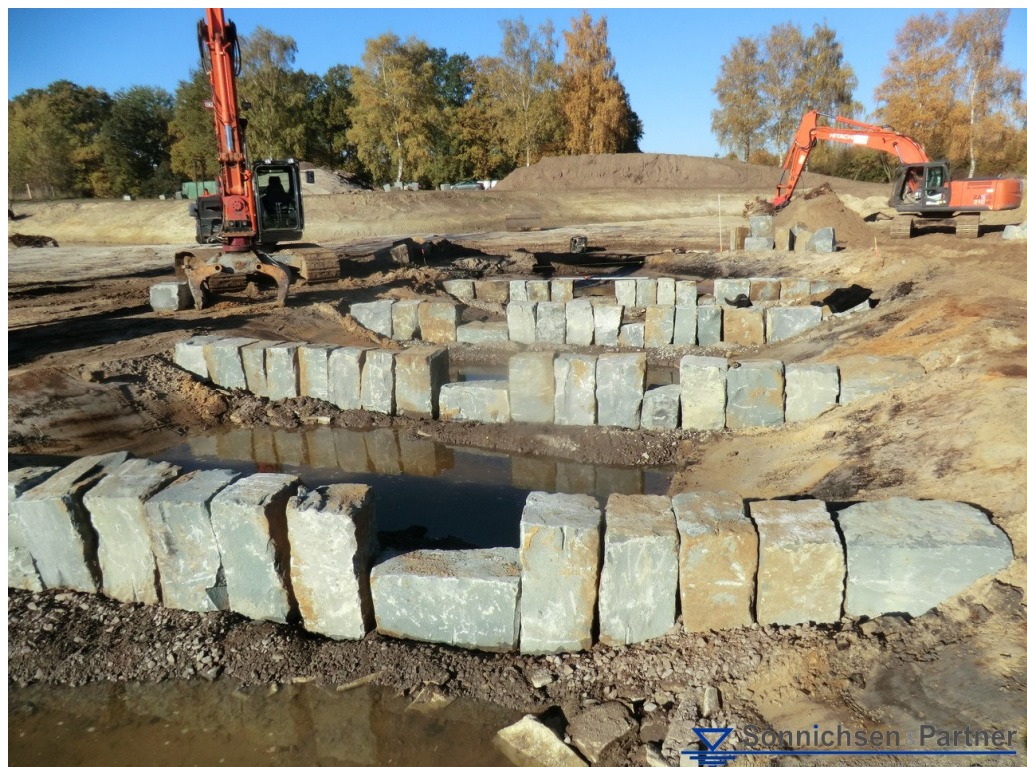
Abbildung 29: Riegel im Bauzustand
