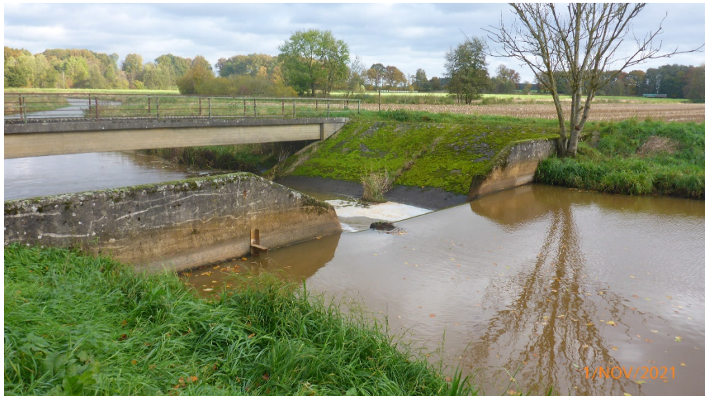
Abbildung 2: Brücke „Hunte“ über die Wagenfelder Aue und Wehr 1 Düster Holz sowie Einmündung in die Hunte
