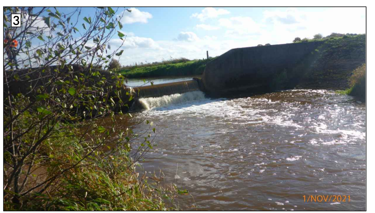
Schwelle Wehr 4 Klärwerk Barver
