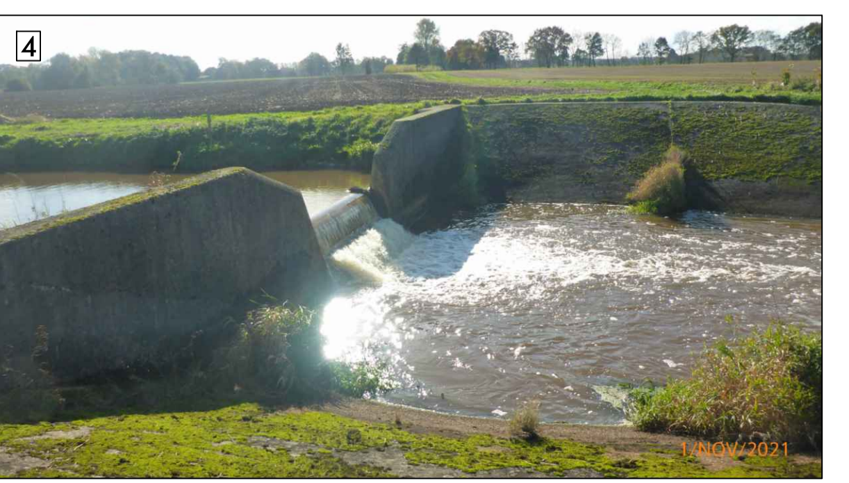
Schwelle Wehr 4 Klärwerk Barver
