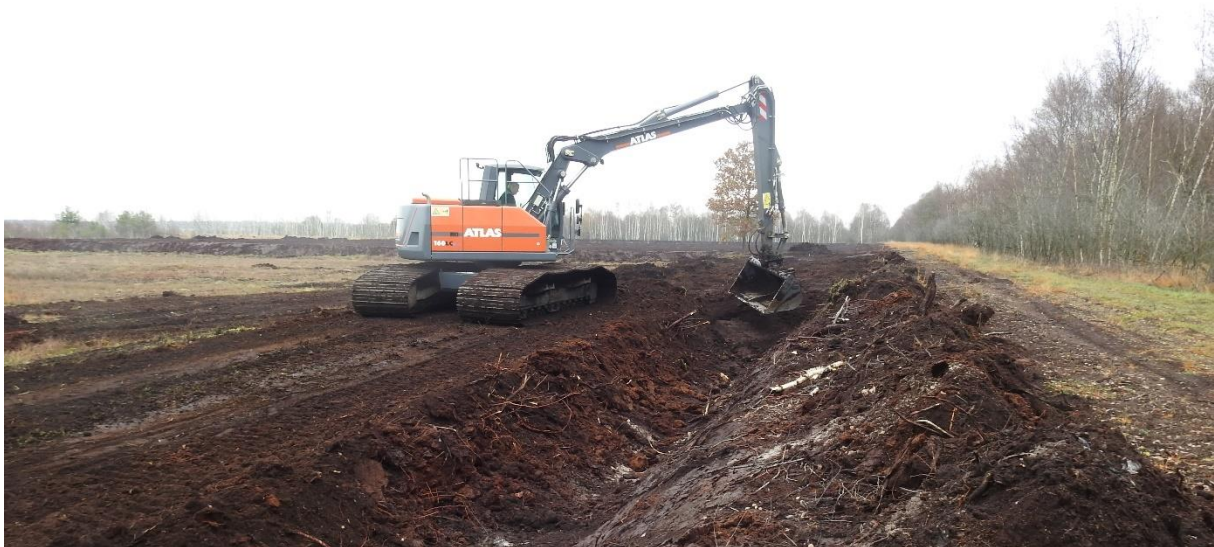
Abb. 3: Graben(teil)verfüllung
