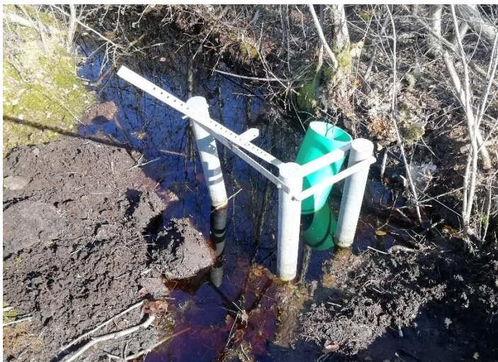
Abb. 4: Überlaufrohr mit zusätzlicher Holzkonstruktion und aufgestecktem Überlaufrohr
