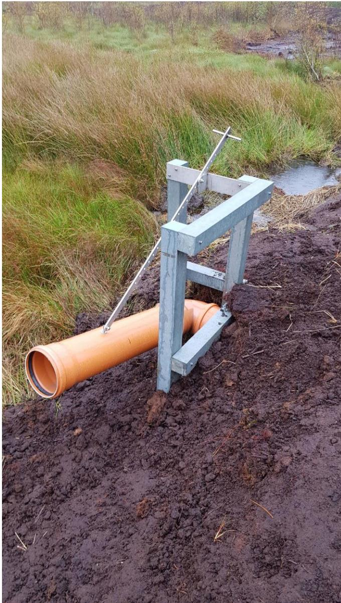
**Abb. 5: Überlaufrohr mit zusätzlicher Konstruktion und aufgestecktem Überlaufrohr**
