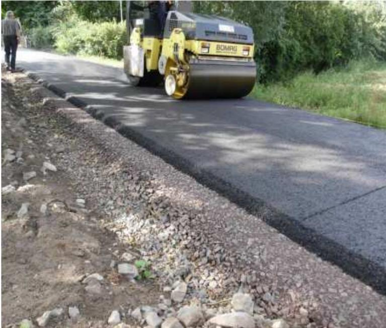
**Abb. 5** Wegebau: Bitumen-Decke
